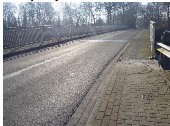
Abbildung 58: Engstelle Kanalbrücke K 147
