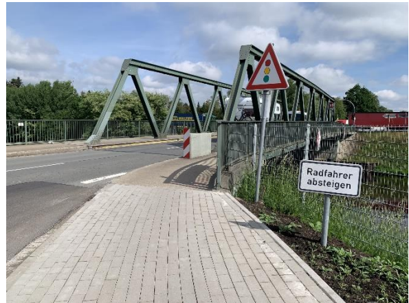
Abbildung 56: Engstelle Kanalbrücke Süddorf
