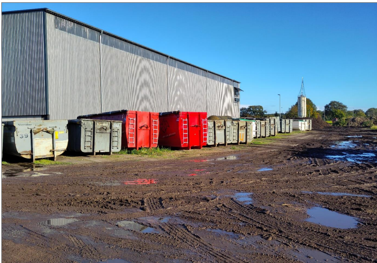
Abb. 11: Geschlossene Halle, Container und vegetationsloser unbefestigter Platz
