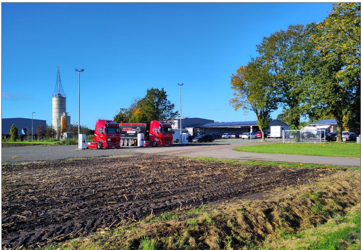
Abb. 17: Firmengelände mit Ladesäulen und Parkplatz
