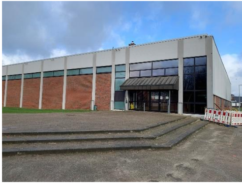
sanierungsbedürftiges Sporthallengebäude „Großer-Kamp-Ost“
