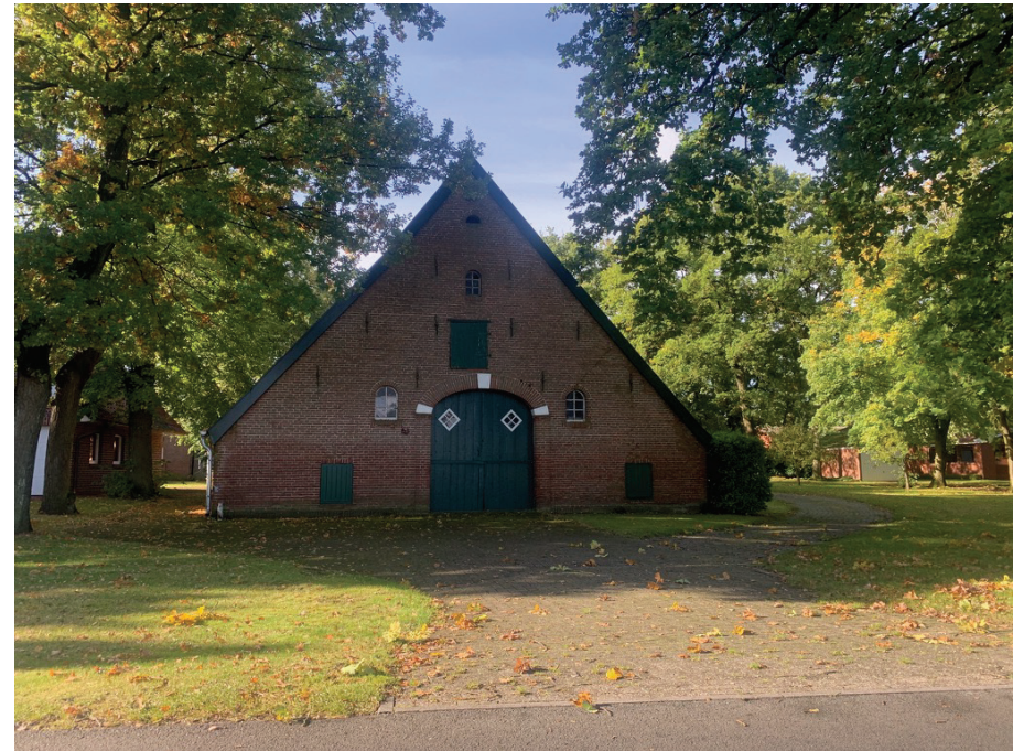
Abbildung 9: Ein älteres, sanierungsbedürftiges Gebäude aus Gehlenberg als Hallenhaus.
