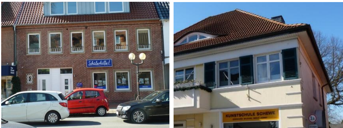
Abbildung 9: Beispiele für ungeteilte Fenster im „stehenden Format“ (links: Lange Str. 3) und Fenster- teilung durch glasteilende Sprossen (rechts: Kirchstraße 11) (Quelle: SWECO 2014)
