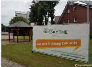
So sieht der Pavillon am Marktplatz nach der Sanierung aus.
